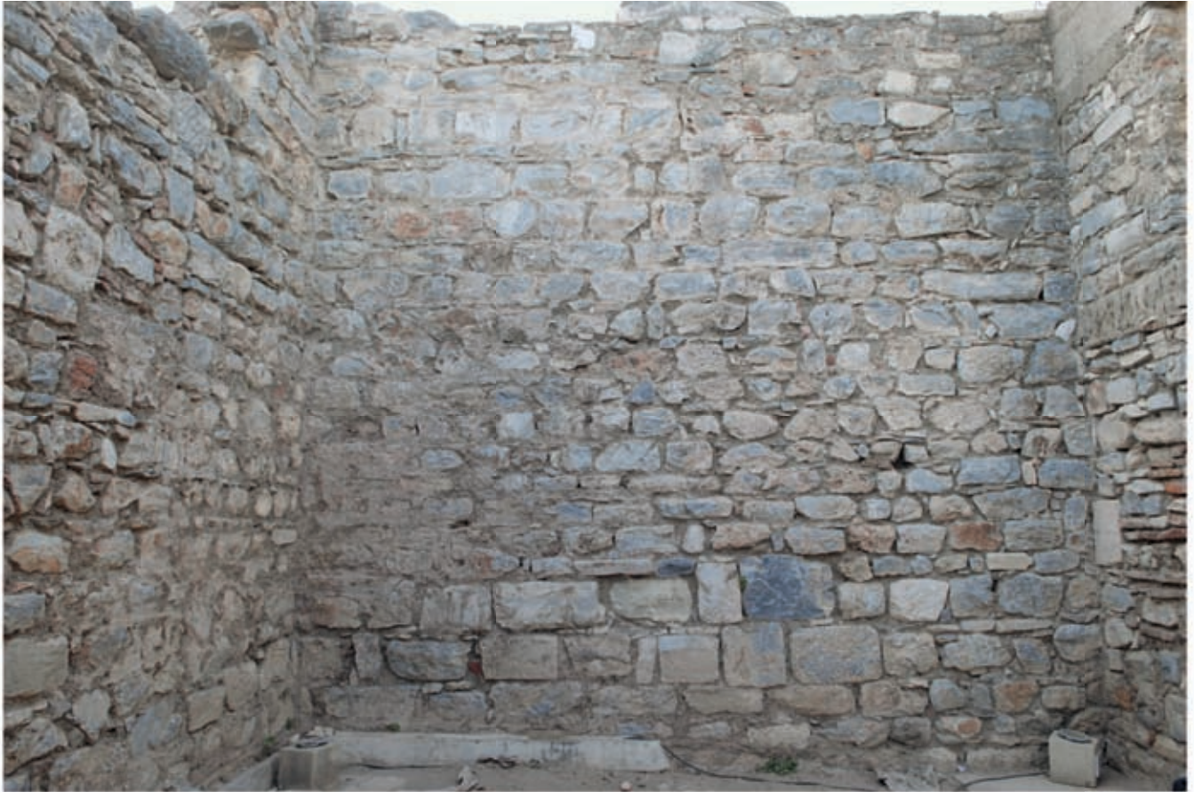
1 Ostwand des Innenraumes
