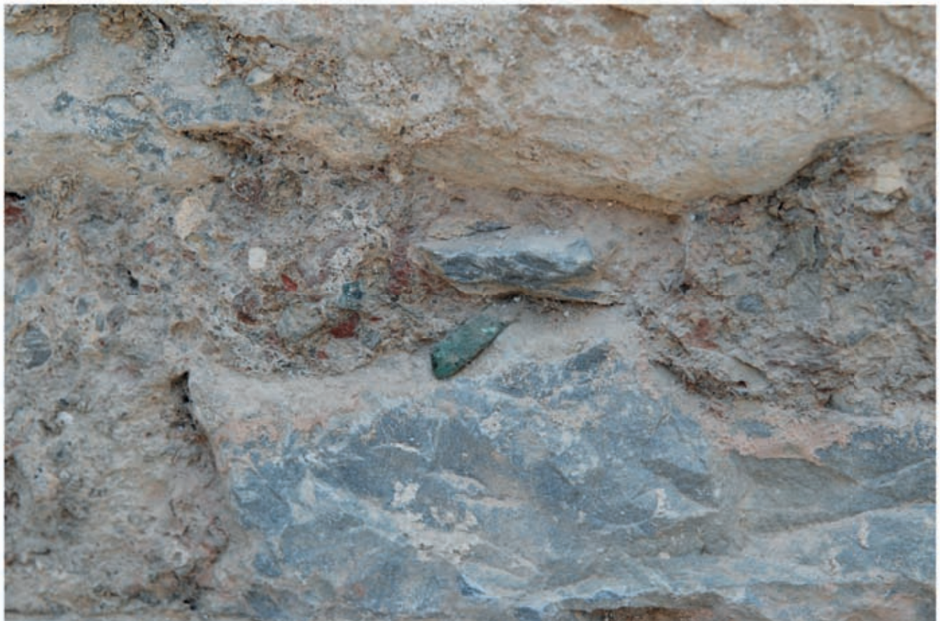
2 Bronzehaken zur Befestigung der marmornen Wandverkleidung
