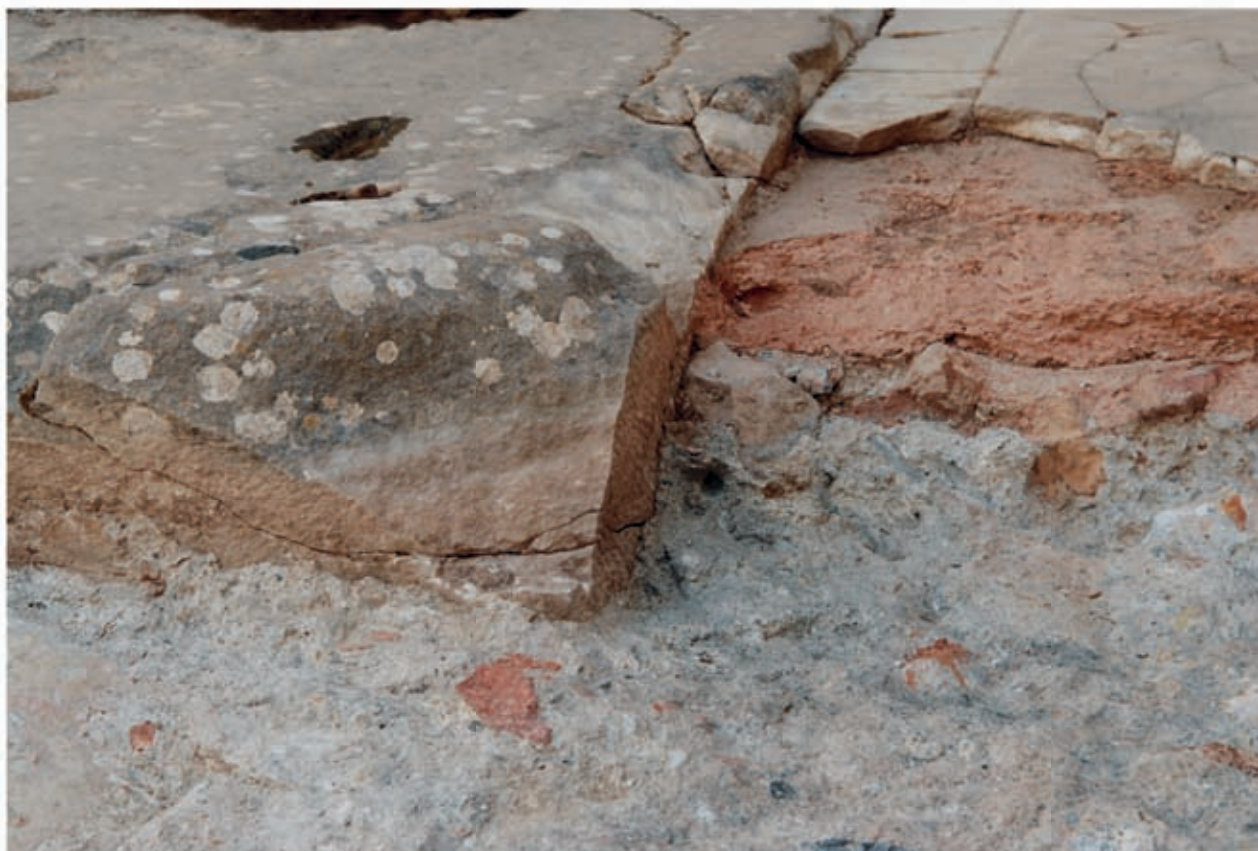
2 Südöstlicher Quader des Podestes mit Einbindung in das Fundament aus opus caementicium
