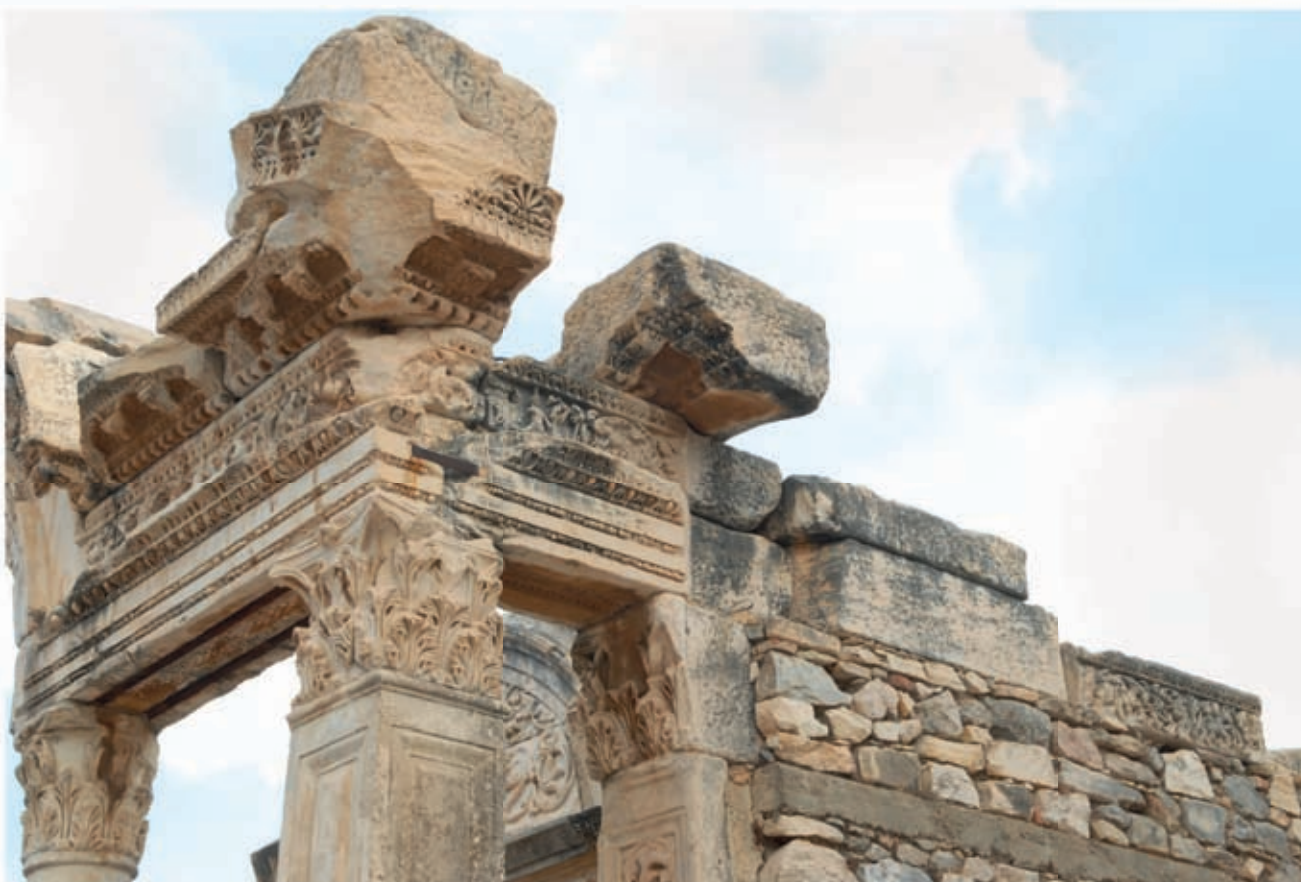
2 Ostseite des Tempels mit Anschluss der Gebälkzone an die Bauglieder über dem Treppenaufgang
