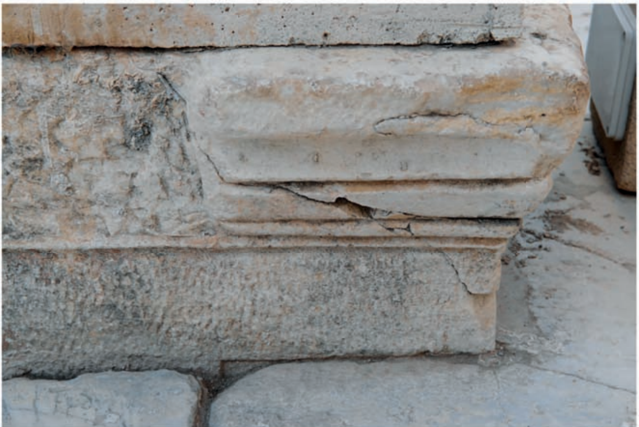
2 Anathyrose an der Ostseite des Säulenpostaments 019B
