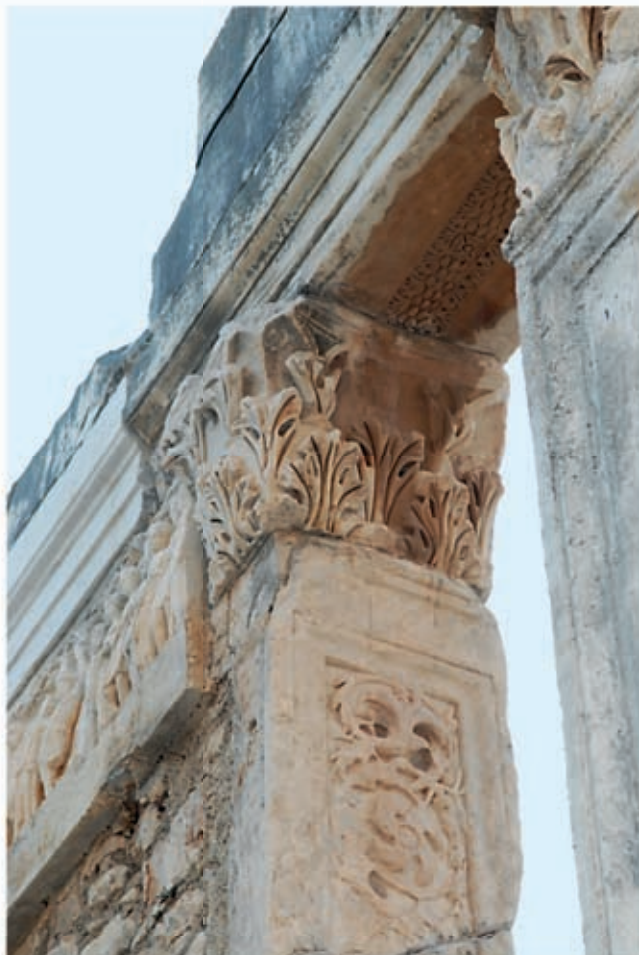
2 Kapitell 028K und oberer Teil des Pilasters 027S
