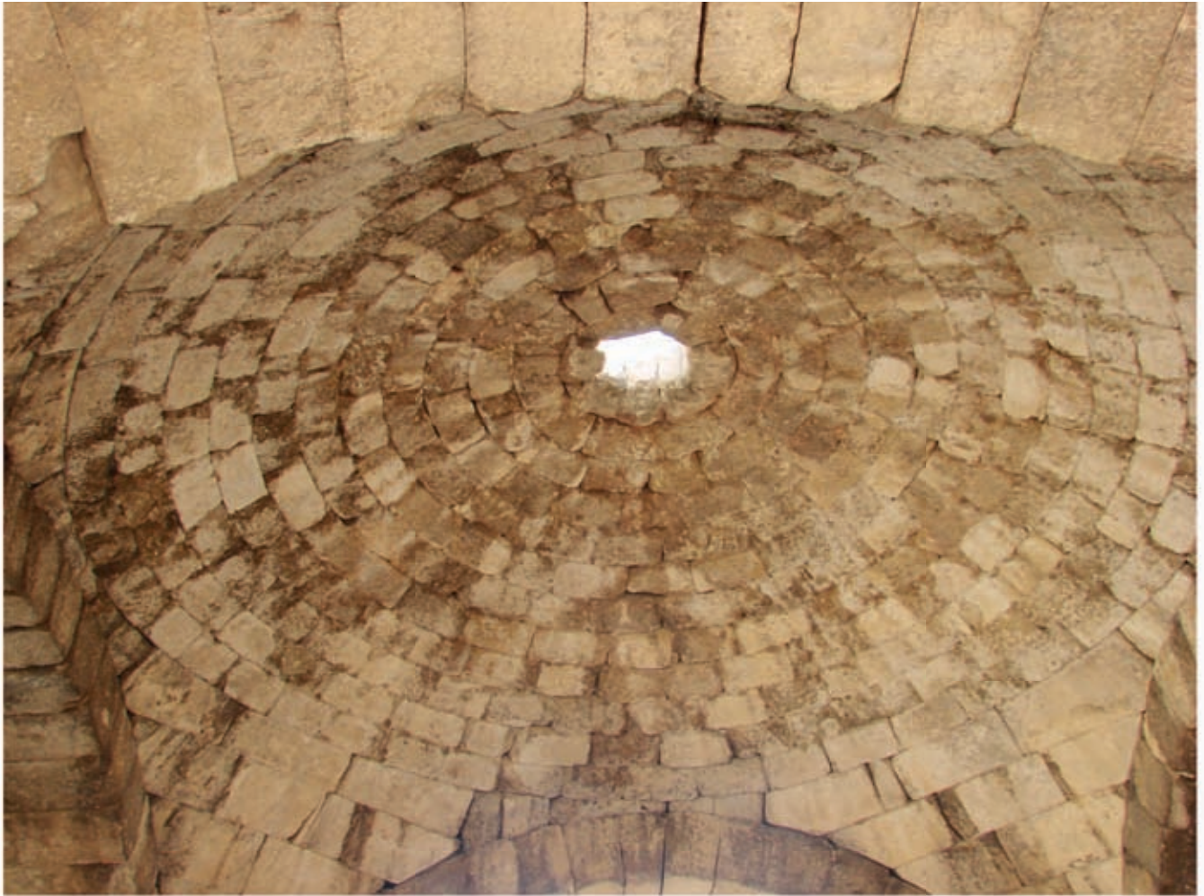
1 Gerasa, Stutzkuppel des Torbaus
