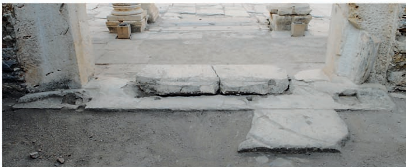
2 Türschwellen 145P und 146P, vom Innenraum aus gesehen
