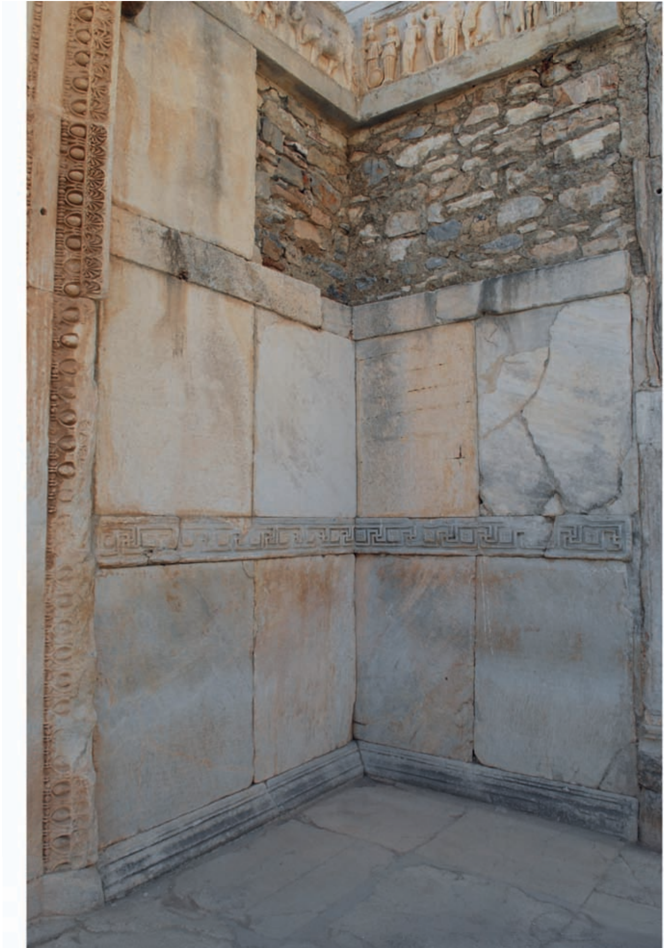
Nordostecke des Pronaos
