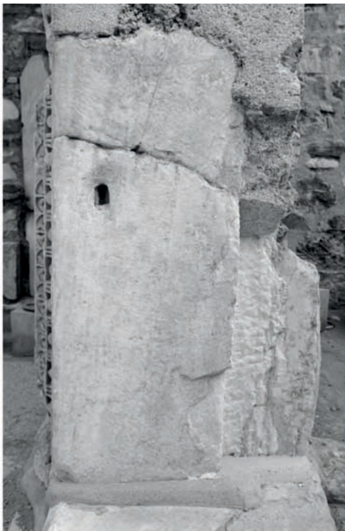
1 076T vom westlichen Türrahmen nach teilweiser Entfernung der Betonergänzung im Jahr 2011
